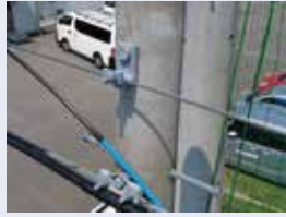
電柱・ケーブル点検
